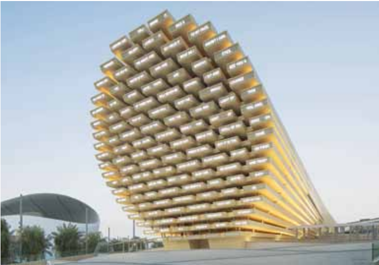
GRANDE-BRETAGNE. Cône en bois CLT et algorithme composant un poème (Es Devlin, artiste et designer, avec Atelier One, ingénieur structure).
